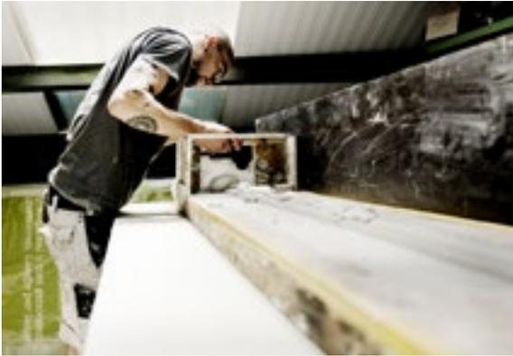
↑ Con medios sencillos y con el método de toda la vida, Sam Kerckaert fabrica una moldura de estuco en la planta superior del taller.
