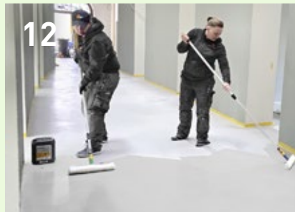
Se aplica el intensificador de color con un paño de piel de cordero y, por último, se sella el suelo sin juntas con un sellado 2K PU para protegerlo de la suciedad.
