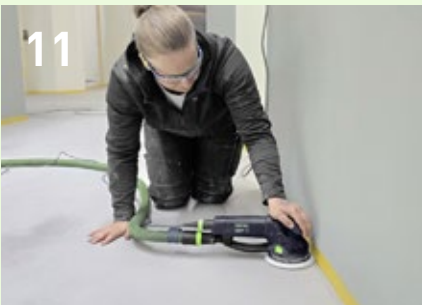
Se lija toda la superficie del suelo: en superficies grandes, con una lijadora de disco Trio; en los bordes y en las zonas de difícil acceso, con la ROTEX RO 150 o RO 90.
