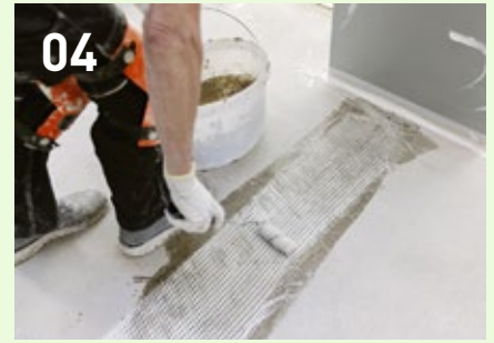
Se colocan conectores ondulados en los fresados y se sellan con resina. A continuación, se aplica tejido de fibra de vidrio y se lija con arena de cuarzo.
