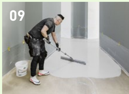
Se vierte la masa para suelos sobre el sustrato y se distribuye uniformemente con una rasqueta. Si se utiliza Pandomo Floor Plus, se esparce arena de grano duro sobre la masa para suelos.
